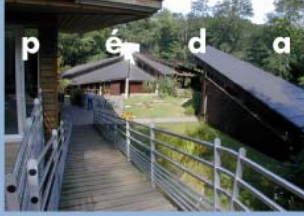
Centre du Graoux à Belin-Beliet
