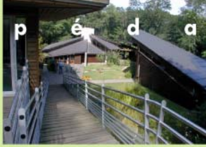
Centre du Graoux à Belin-Beliet
