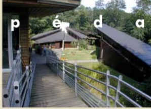
Centre du Graoux à Belin-Beliet
